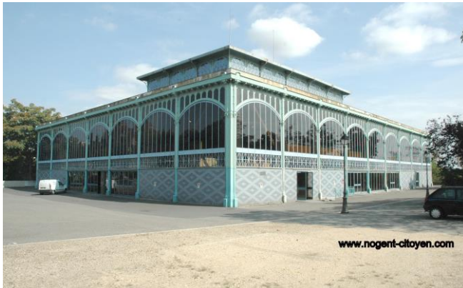
Le Pavillon Baltard de Nogent-sur-Marne reconstruit en 1976
