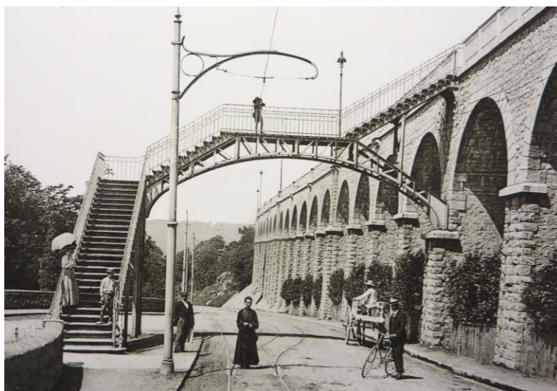
On retrouve poteau et volute soutenant les caténares des lignes de tramways palois sur une carte postale de 1904.
