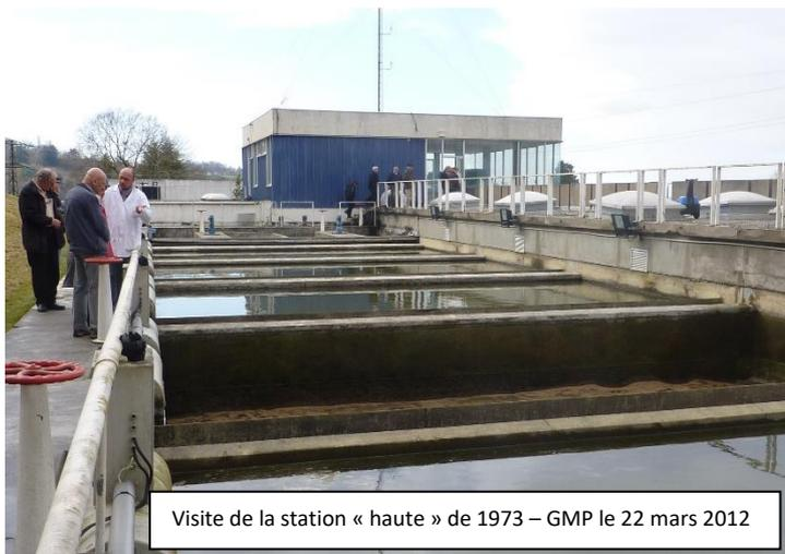
Simultanément, de nouveaux travaux débutèrent à la station de Guindalos en 1970 pour s'achever en janvier 1973 afin de construire une nouvelle station « dite haute » à la côte de 264m. Ce nouvel équipement permit d'augmenter la pression de distribution de 4 bars à 6 bars, et de distribuer jusqu'à 30 000m<sup>3</sup>/jour à travers 237 km de tuyauteries. A noter que la population était montée à 90 000 habitants et le besoin journalier à 300 l/jour/personne.
